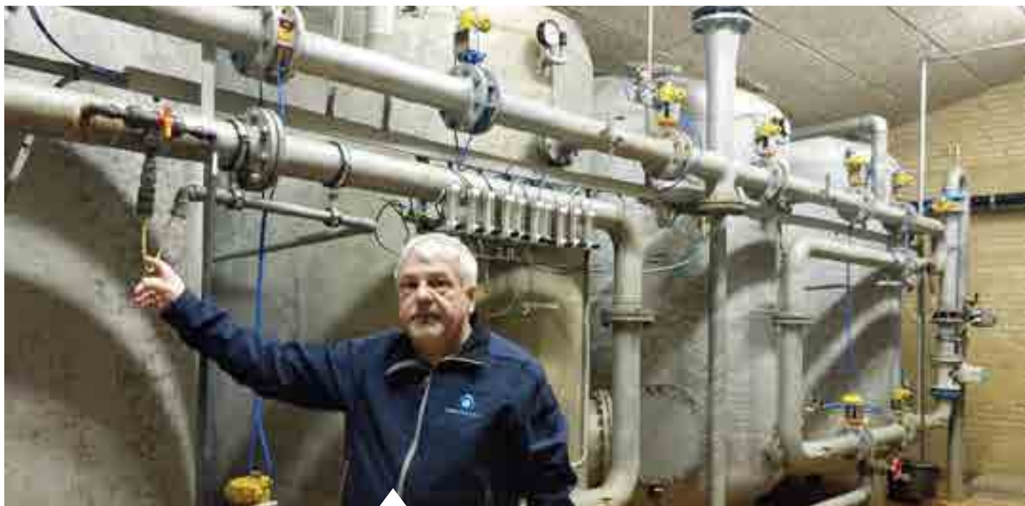
Kemiker og formand for Galten Vandværk i Østjylland Kim Kusk Mortensen står ved det rør, hvor der injiceres jernsalte til filter to og arsen udfældes.
