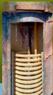
Kalkknuser-behandlet varmtvandsbeholder fra Langeland. (21 °dH).
