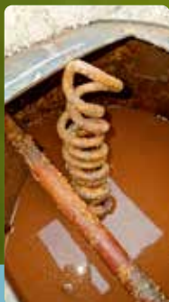
Ubehandlet varmtvandsbeholder fra Lejre. (17 °dH).
