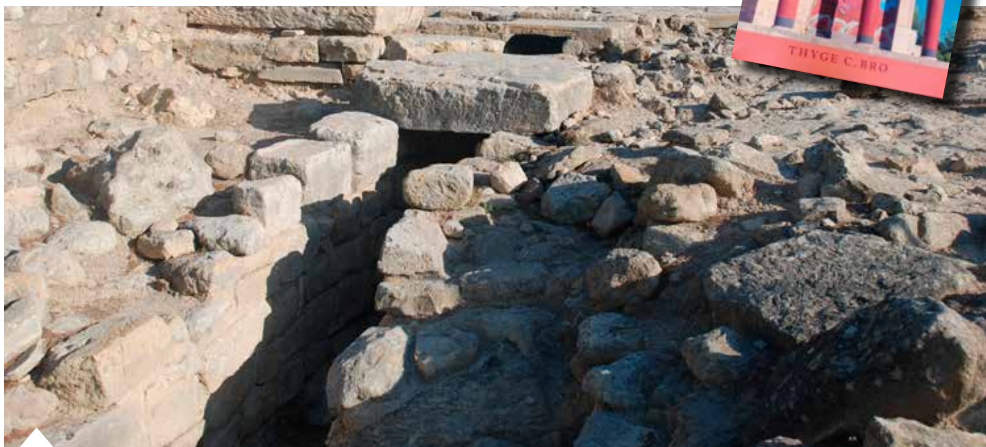
Drænelingen eller kloakken under centralgården i Phaistos havde dimensioner, så der kunne sendes folk derned via skakter til at foretage vedligeholdelse, og der var derfor også sikret ventilation.
