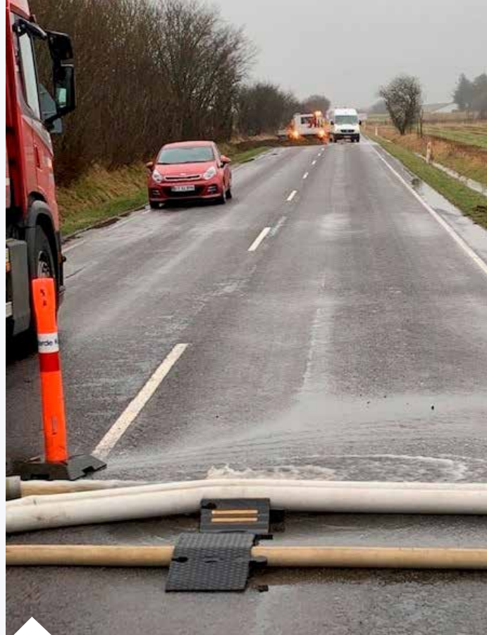
Landevejen foran vandværket, hvor beredskabet er i gang med at pumpe.
