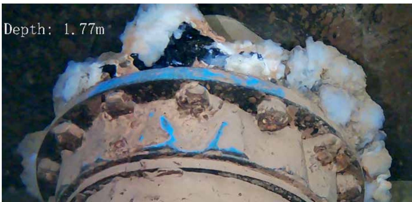
Dronebillede fra tank 4: Flangen er tæt.
