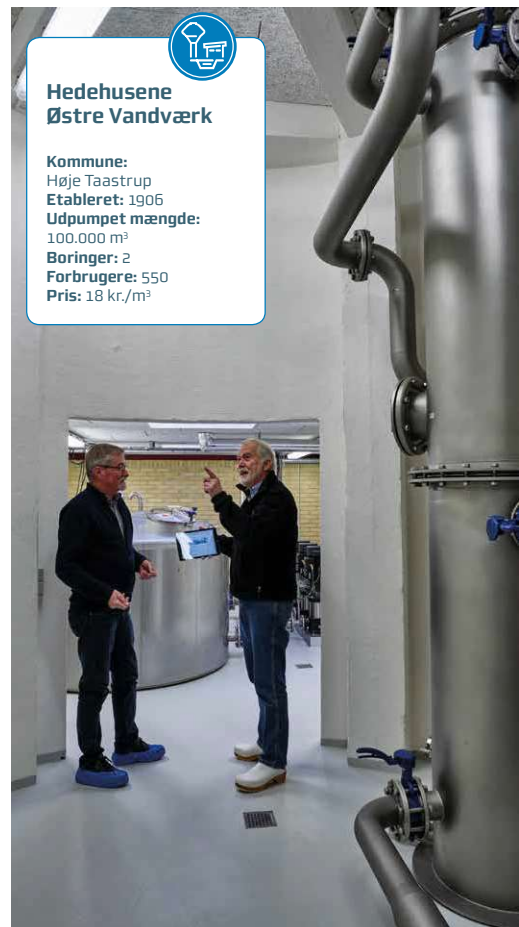
Karsten Skydsgaard (tv.) og Poul-Henrik Larsen i det topmoderne vandværk. I det gamle vandtårn står de to beluftningssøjler.
